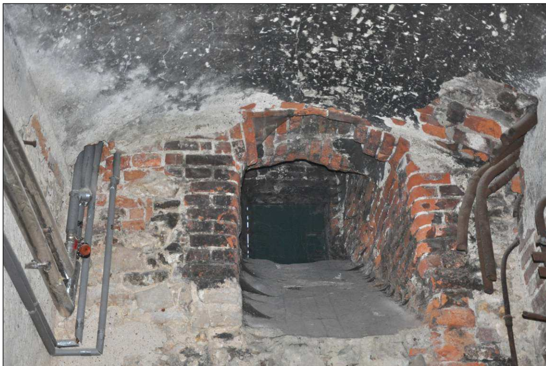
Okienko w ścianie komory nr -1.3
