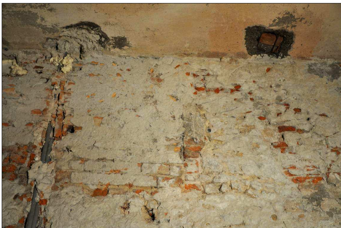
Fragment ściany szczytowej komory nr – 1.4
