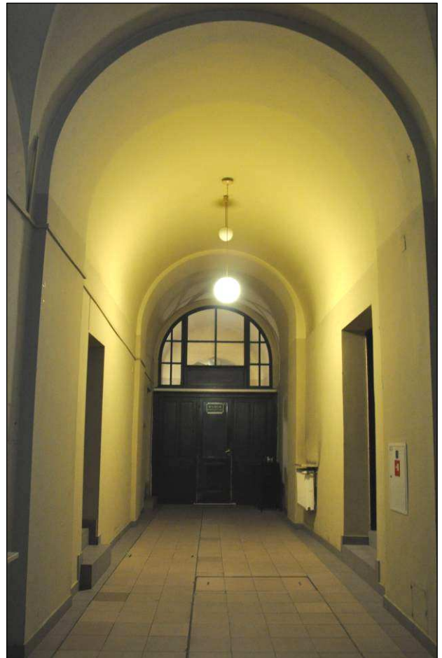
Fot. 29 Kraków, Stary Teatr, plac Szczepański1/ul. Jagiellońska 1 – parter, sień wjazdowa, widok od strony wejścia. Współczesne wyprawy tynkowe i opracowanie malarskie , posadzka z gresu. Stan zachowania przed konserwacją Grudzień 2011r, M.Wida
