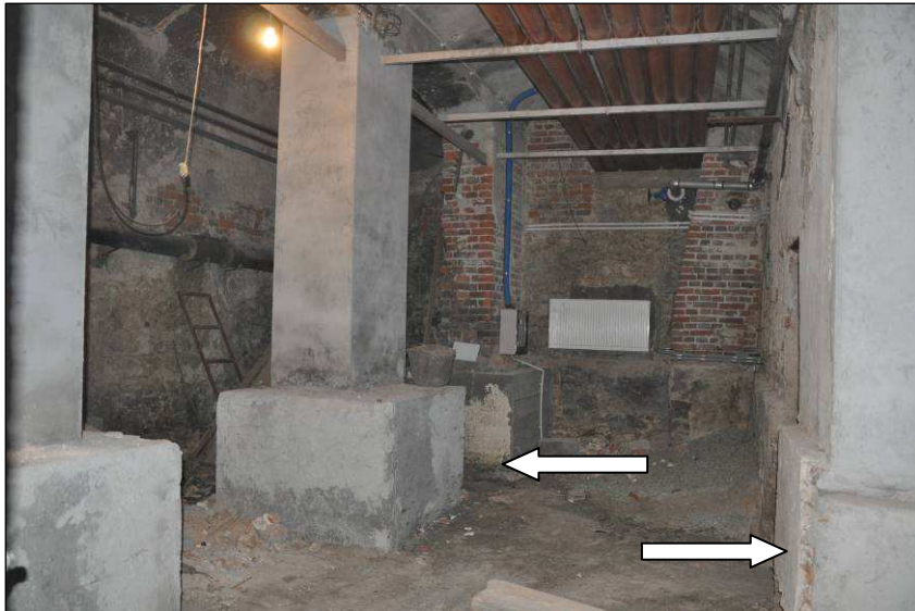
Komora -1.3 ściana na wprost i ściana po lewej w pierwotnych wątkach kamiennie- ceglanych, sklepienie kolebkowe. Po środku pomieszczenia i z prawej strony filary z czasów przebudowy z początku XX wieku
