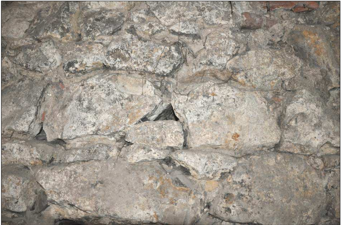
Fragment kamiennych wątków ściany komory -1.2. Wapień jurajski na zaprawach wapienno-piaskowych
