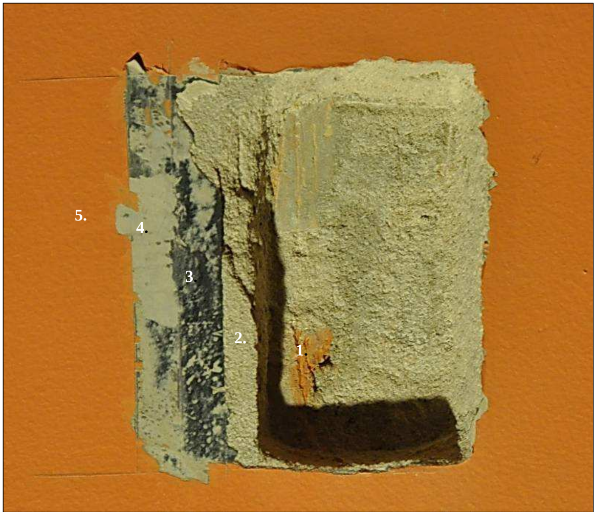
Odkrywka 1b (1,5m od posadzki)
