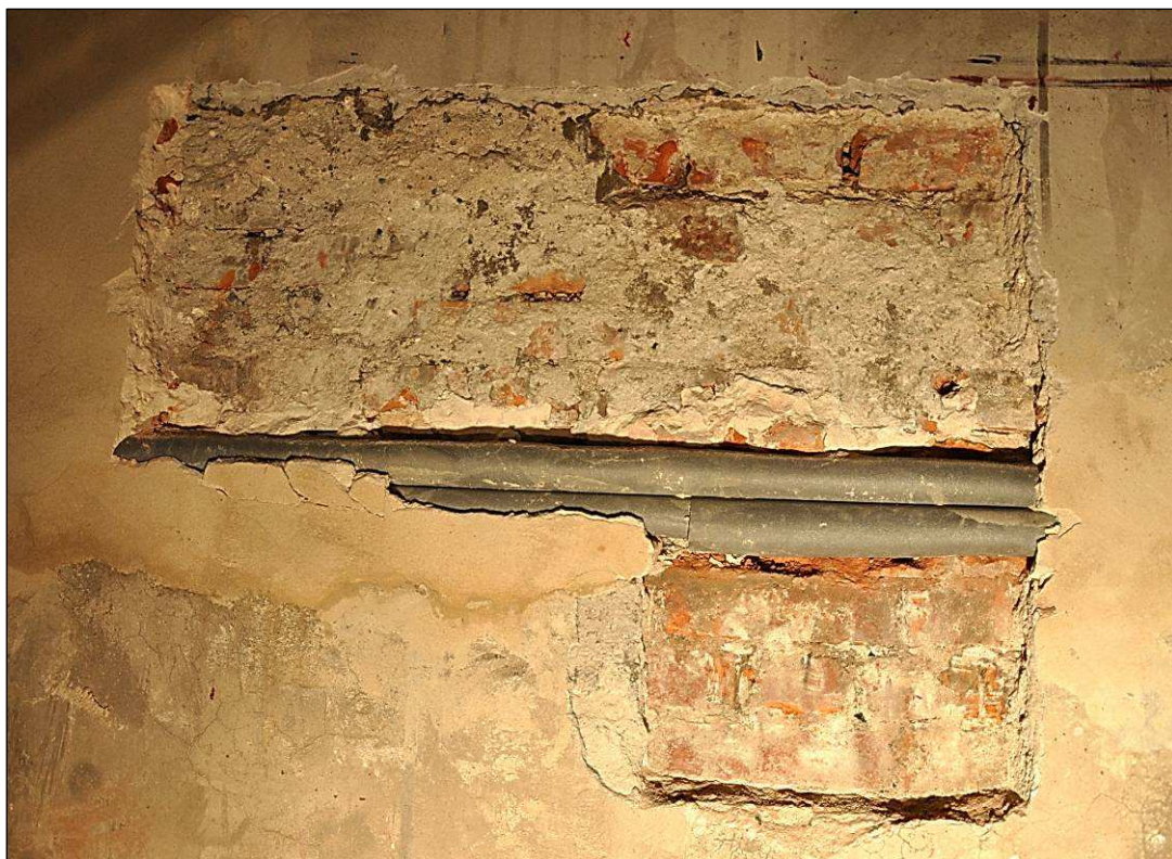
Odkrywka 3, komora nr -1.4
