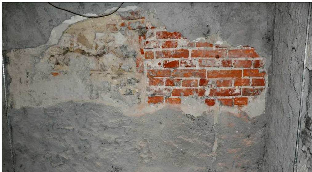
Odkrywka 1, komora nr -1.1
