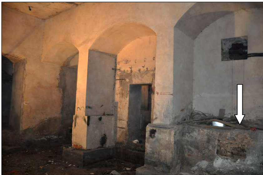
Komora - 1.4 Ściany murowane na pocz. XX wieku, w prawym dolnym rogu zachowany fragment gotyckiej ściany. Strop płaski, żelbetowy
