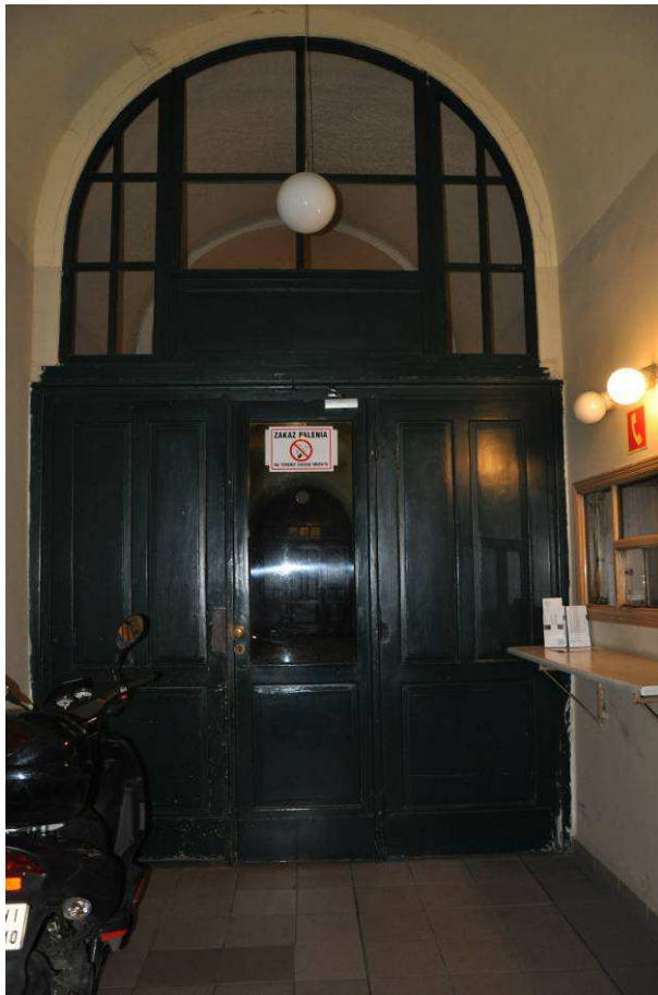
Fot. 28 Kraków, Stary Teatr, plac Szczepański1/ul. Jagiellońska 1 – parter, sień wjazdowa, widok od strony wejścia na portiernię. Stan zachowania przed konserwacją Grudzień 2011r, M.Wida
