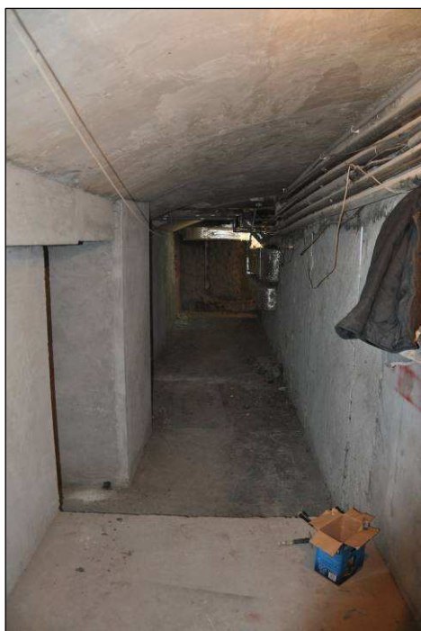
Komora -1.1 Korytarz łączący komory -1.2, -1.3, -1.4 Sklepienie kolebkowe, ściany w wątkach kamiennych przykrytych tynkiem i szprycom cementowym.
