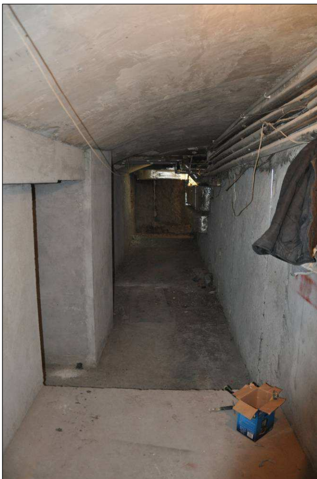
Fot. 1 Kraków, Stary Teatr, plac Szczepański1/ul. Jagiellońska 1 – piwnice, komora nr -1.1(korytarz). Ściany w wątkach kamiennych przykrytych tynkiem i szprycem cementowym. Stan zachowania przed konserwacją Grudzień 2011r, M.Wida
