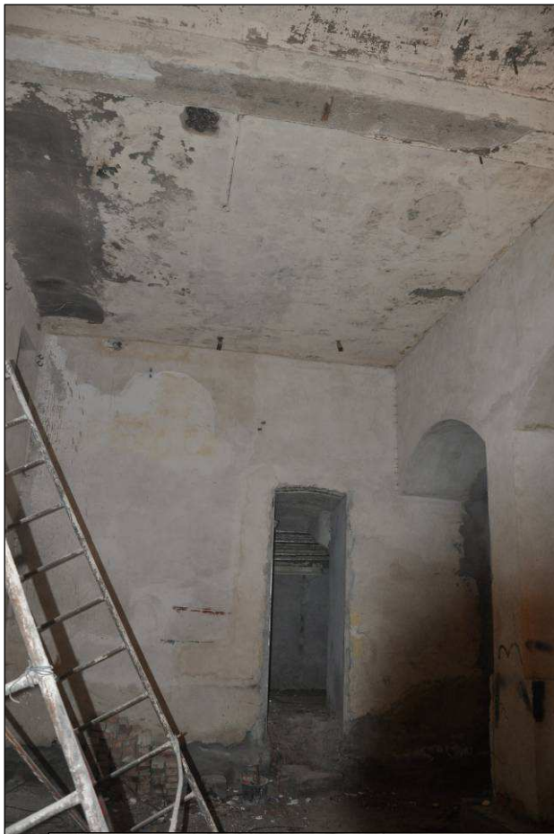
Fot. 13 Kraków, Stary Teatr, plac Szczepański1/ul. Jagiellońska 1 – piwnice, komora nr -1.4. Widok na ścianę z wejściem. Ściany i strop tynkowane. Stan zachowania przed konserwacją Grudzień 2011r, M.Wida
