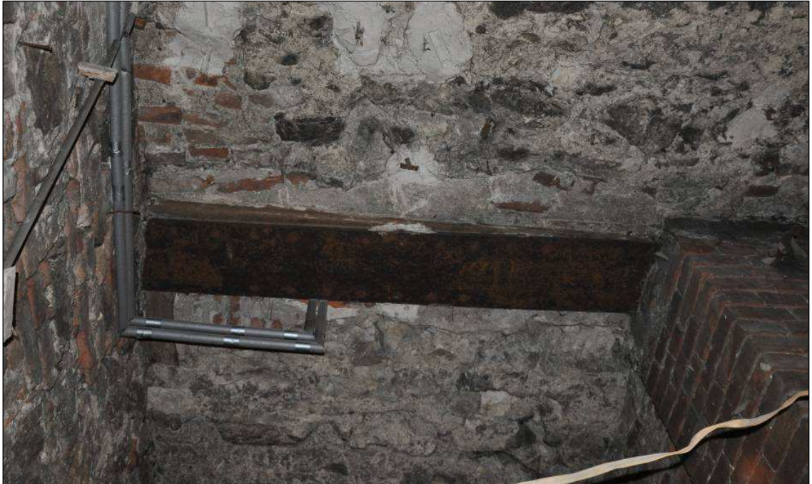
Fragment sklepienia kamiennego z szalunkami w komorze -1.2. Na filarach i ścianie wsparto podciąg metalowy dla ścian wyższych kondygnacji (sien)
