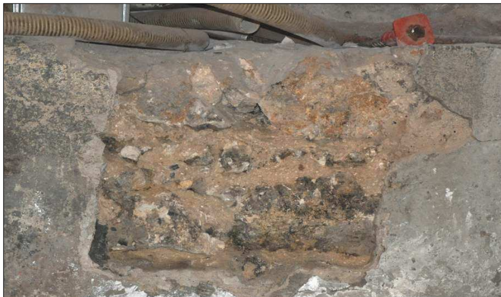
Odkrywka 2, komora nr -1.4
