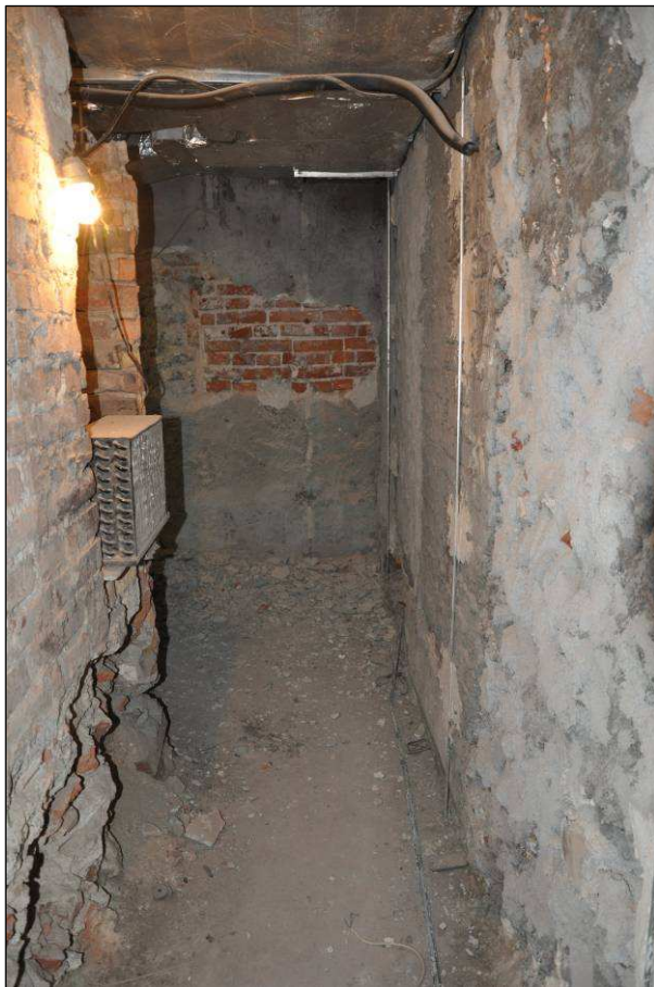
Fot. 2 Kraków, Stary Teatr, plac Szczepański1/ul. Jagiellońska1 – piwnice, komora nr -1.1(korytarz) Odkrywka nr1 na końcu korytarza, zamurowane przejście. Stan zachowania przed konserwacją Grudzień 2011r, M.Wida
