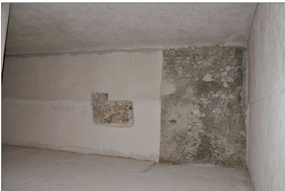
Fot.5 Piwnice Starego Teatru w Krakowie, pom. nr -1.7, widok na ścianę od strony placu Szczepańskiego. Odsłonięte wątki kamienne do zatynkowania w części opisowej określone jako zad.1). Czerwicz, M.Wida
