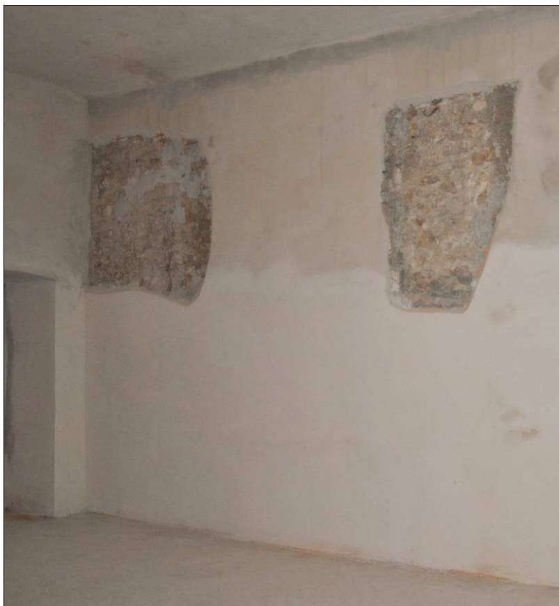
Fot.4 Piwnice Starego Teatru w Krakowie, pom. nr -1.6, widok na ścianę od strony placu Szczepańskiego. Odsłonięte wątki kamienne do zatynkowania (w części opisowej określone jako zad.1). Czerwicz, M.Wida
